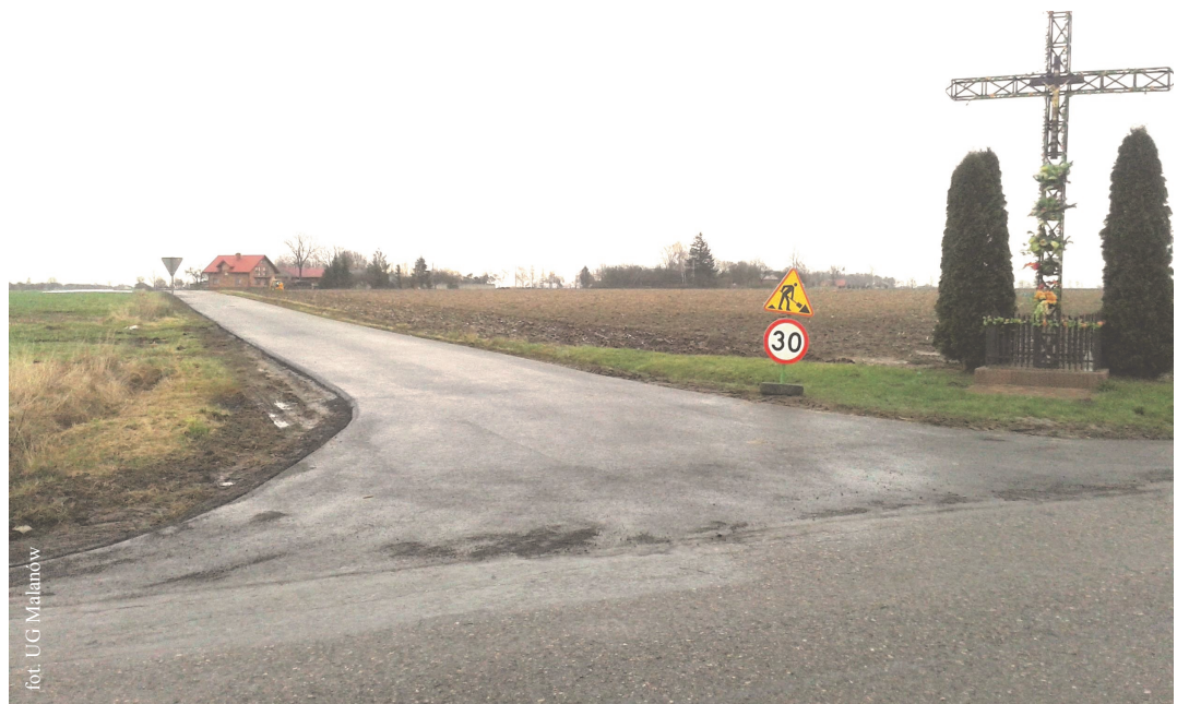
Wyremontowany odcinek drogi
